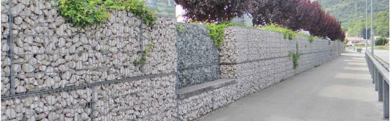
**Figura 2-24: Tipico di recinzione con muro in gabbione armato e sassi (fonte: OW\_ITA\_CLB\_GEN\_OWC\_ENV\_DWG\_70).**
