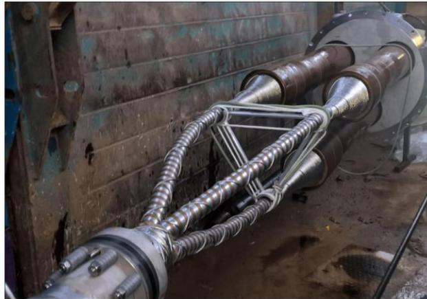
**Figura 2-6: Tipico di giunto di transizione tra cavi marini e terrestri**
