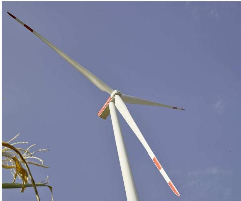
**Figura 2-29: esempio di turbina con bande rosse e bianche**
